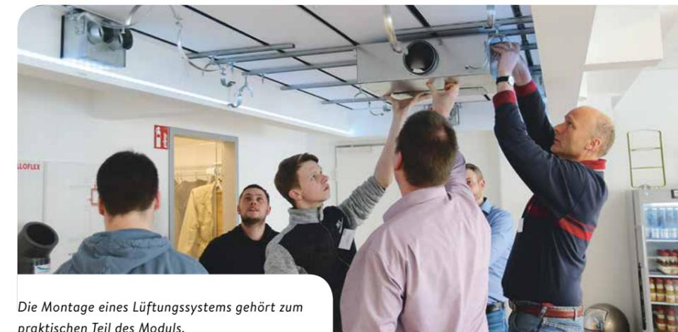
Die Montage eines Lüftungssystems gehört zum praktischen Teil des Moduls.
